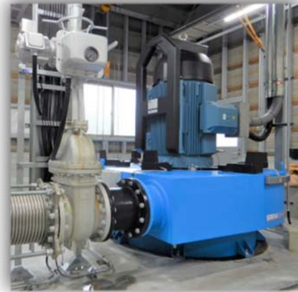
農業用水を活用した小水力発電 吉野小水力発電所(上松町)
