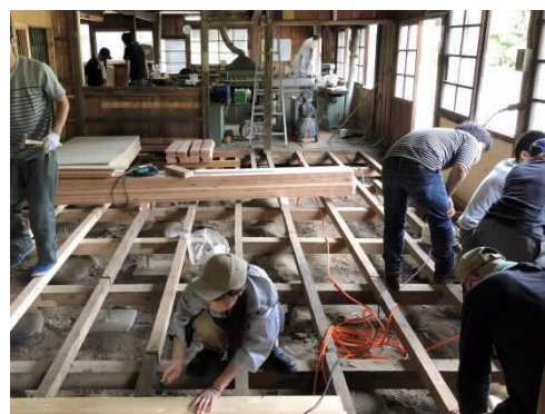
【拠点整備の様子】
