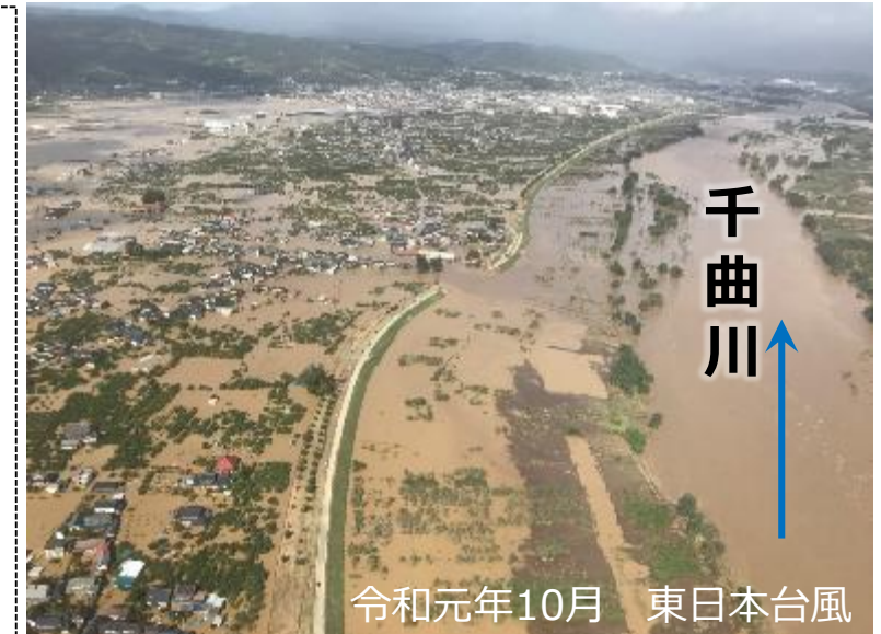
令和元年10月 東日本台風 千曲川堤防決壊（長野市穂保）
