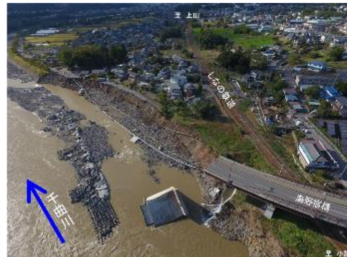
東日本台風による河川護岸の欠損と道路橋の損壊のため鉄道が運休 災害に強いインフラの整備が求められている
