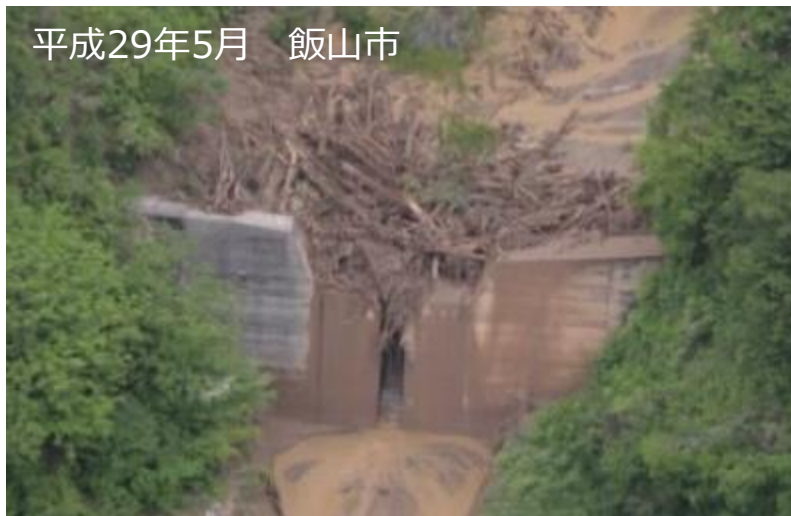
平成29年5月 飯山市 本砂防堰堤がなければ、下流の人家25戸、JR等に甚大な被害
