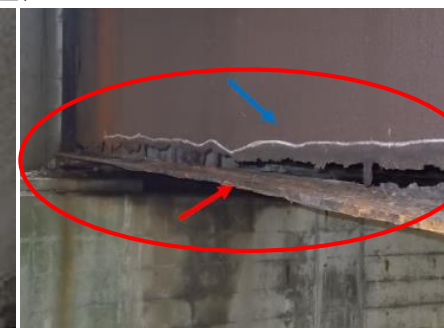
橋梁の桁のひび割れ、腐食
