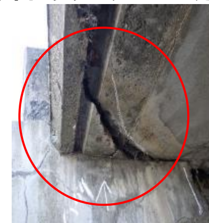
橋梁の桁のひび割れ、腐食
