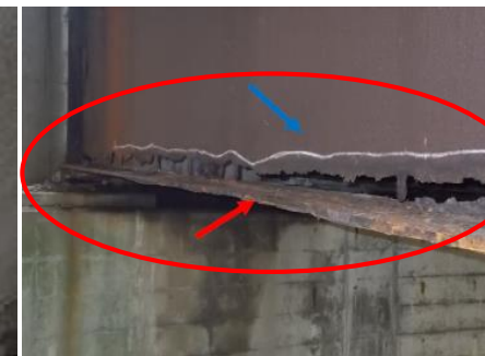
橋梁の桁のひび割れ、腐食
