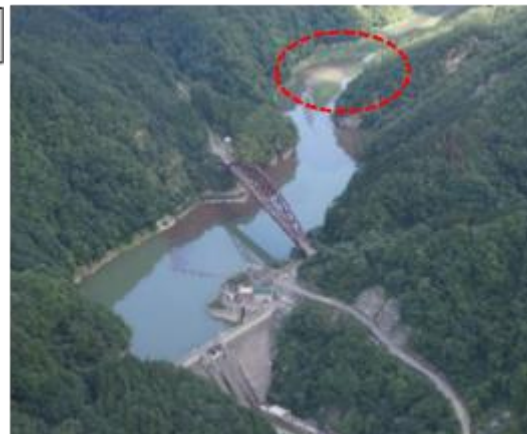
奥裾花ダムの堆砂状況
