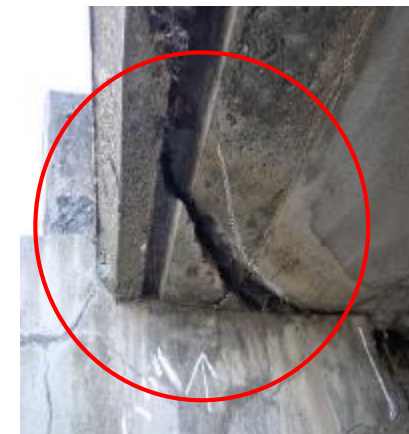
橋梁の桁のひび割れ、腐食
