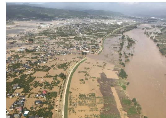
令和元年東日本台風による被害
