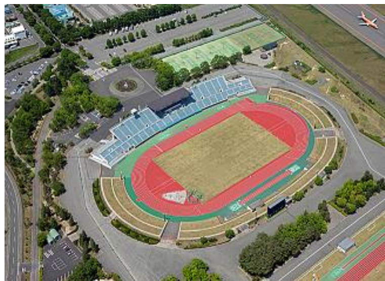
松本平広域公園陸上競技場 (昭和52年度供用開始)
