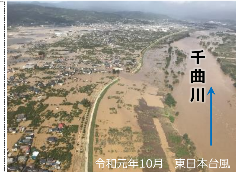
千曲川堤防決壊（長野市穂保） 令和元年10月 東日本台風
