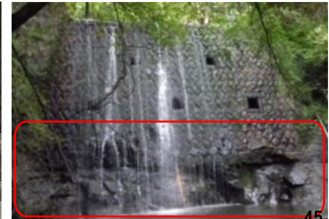
砂防堰堤の基礎洗掘
