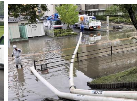
国交省排水ポンプ車の支援
