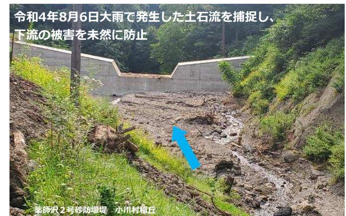
令和4年8月6日大雨で発生した土石流を捕捉し、
