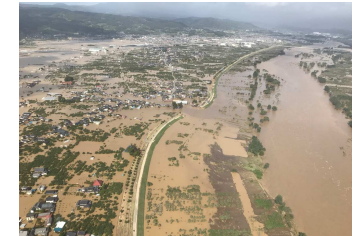
令和元年東日本台風による被害
