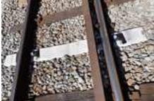
上田電鉄線のマクラギ更新(木⇒コンクリート)<br>
