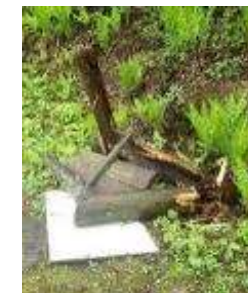
老朽化した標識が 景観の支障に
