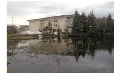
H29に撤去された 志賀高原・蓮池ホテル (跡地は満喫Pで活用)
