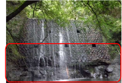
砂防堰堤の基礎洗掘
