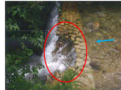
石積堰堤の破損事例
