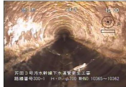
下水管の硫化水素による腐食状況
