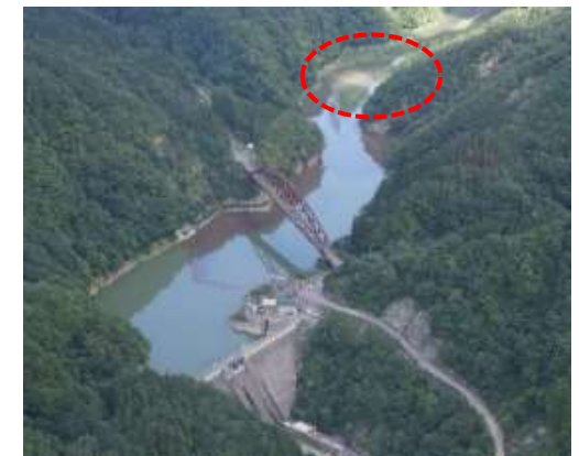
奥花ダムの堆砂状況
