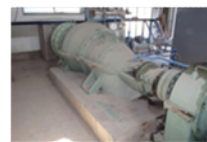
機能が低下した排水ポンプの更新
