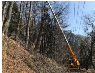
ライフライン沿いの危険木除去作業
