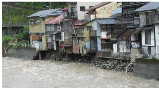
2021年8月豪雨による木曽川沿いの住宅被害(木曽町)
