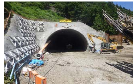
国道158号狸平トンネル工事（松本市）
