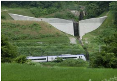
砂防堰堤（小谷村）
