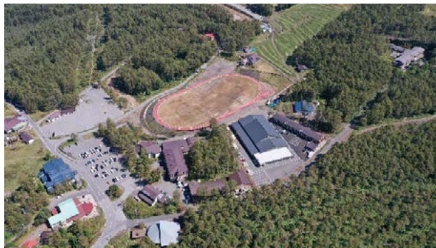
高地トレーニング施設全景（湯の丸高原）
