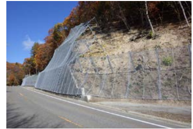
落石対策（大町市）
