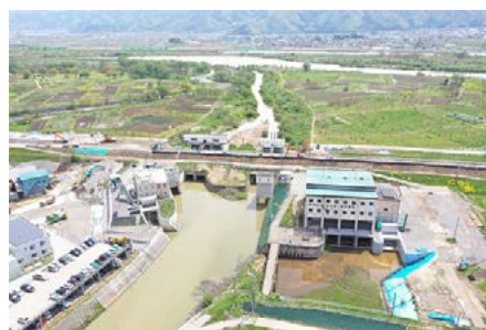
浅川排水機場
