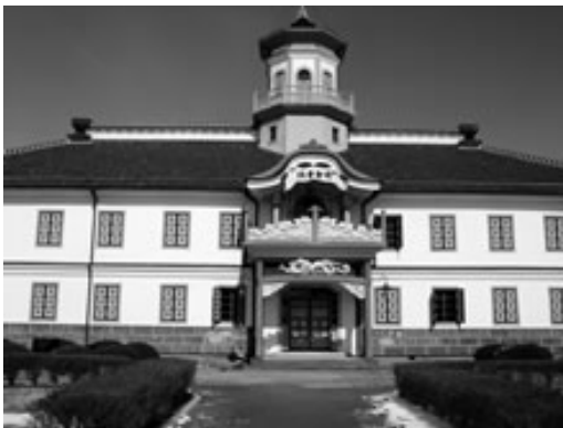
建築費の多くが地元住民の寄付によって 賄われた旧開智学校
