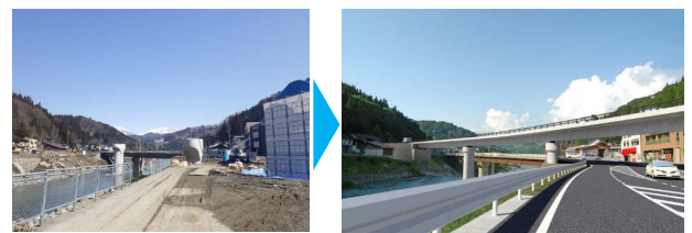
施工状況（2019年3月現在）
