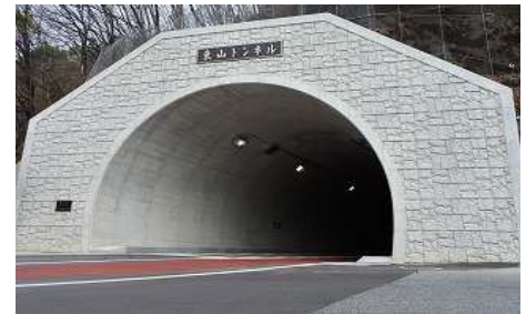
(主)松川インター大鹿線(渡場～滝沢) 東山トンネル
