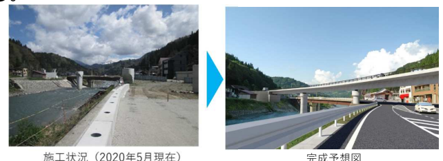
施工状況(2020年5月現在)
