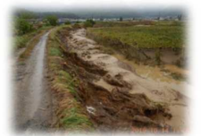
蛭川堤防復旧（長野市東寺尾）
