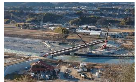
(主)伊那生田飯田線 松川町 宮ヶ瀬橋
