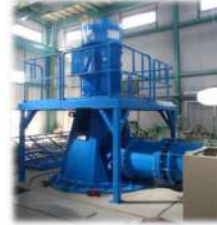
排水機場ポンプ更新（長野市若穂牛島）
