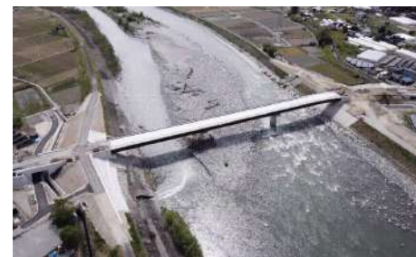
(主)伊那生田飯田線 松川町 宮ヶ瀬橋
