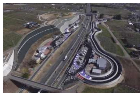
座光寺スマートインターチェンジ
