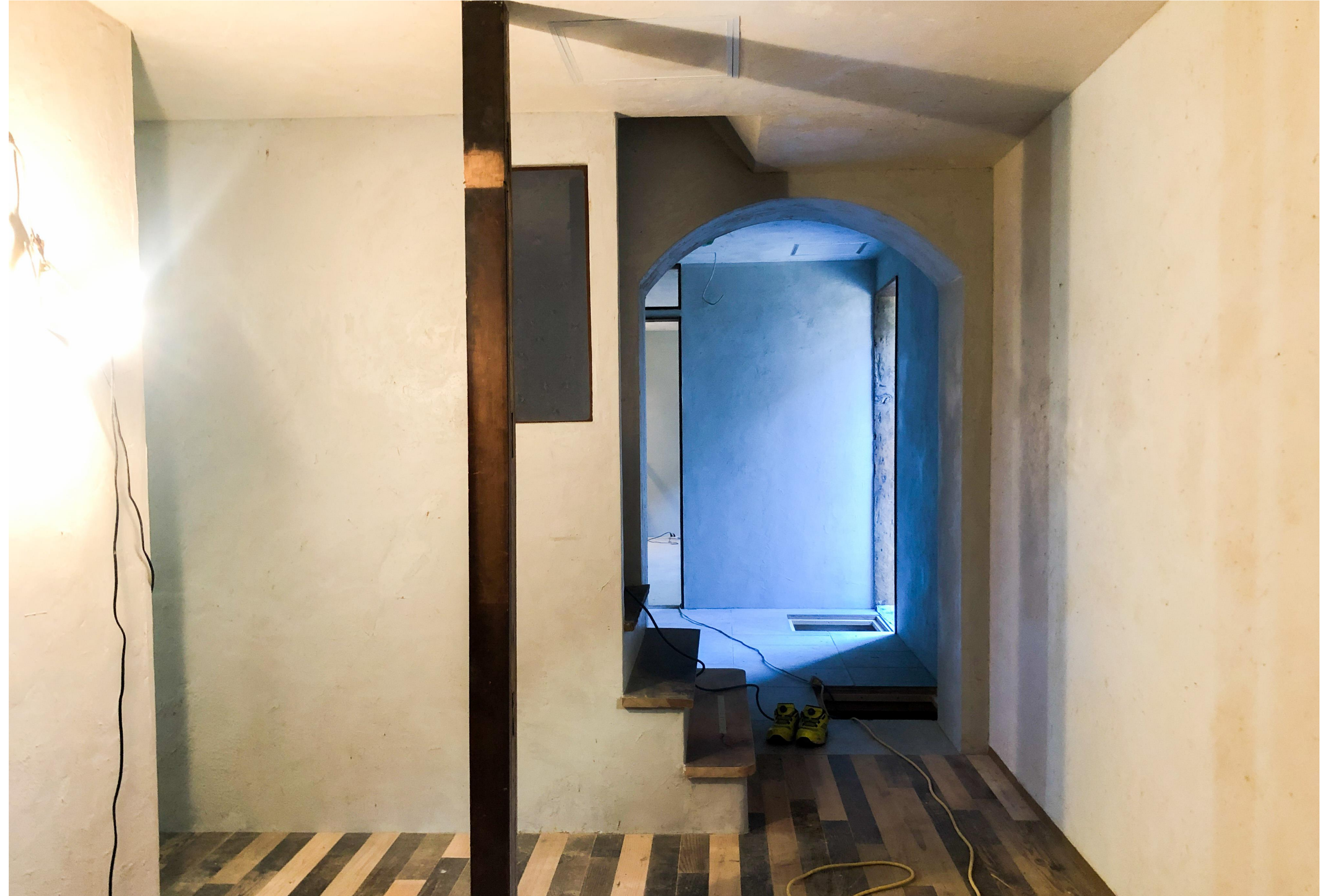
社員用の社宅も断熱改修中
