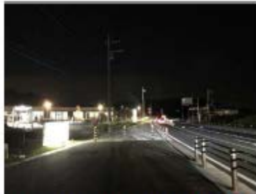
↑周辺が停電する中、照明がついているむつざわSWT 【引用：(株)CHIBAむつざわエナジーHP】
