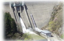
水芭蕉発電所
