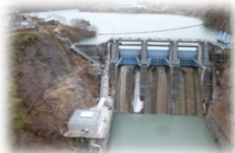
高遠さくら発電所
