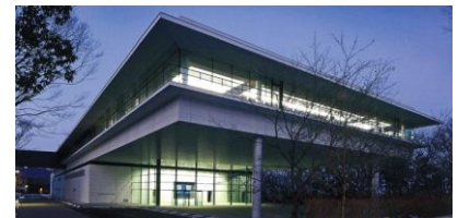
HIOKIイノベーションセンター (H27年4月竣工)
