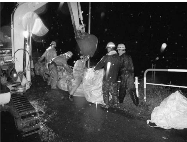
地域で活躍する建設産業 (災害を防ぐための土のう詰め作業)
