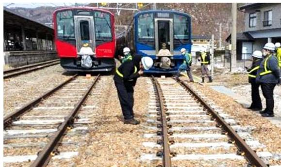
木マクラギ → PC化したマクラギ
