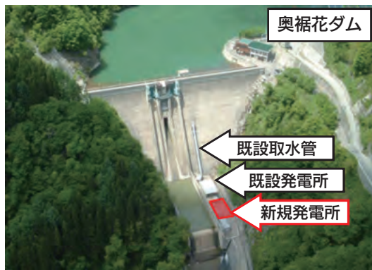
奥裾花第2発電所（建設中）
