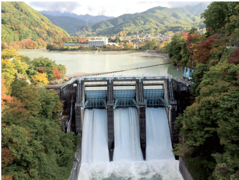
耐震性能照査で安全性が確認された高遠ダム
