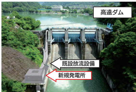
高遠発電所（建設中）
