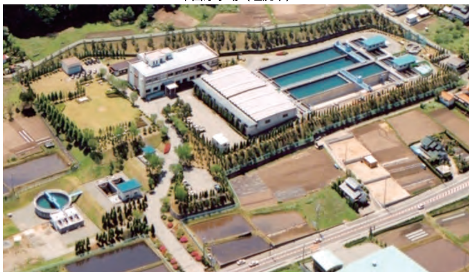
本山浄水場（塩尻市）
