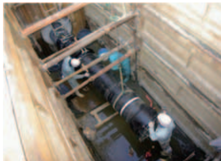
水道管の耐震化工事
