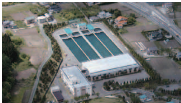
本山浄水場（塩尻市）
