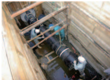
水道管の耐震化工事
