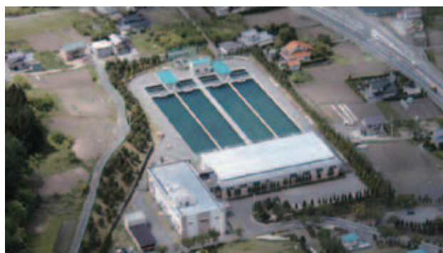
本山浄水場（塩尻市）
