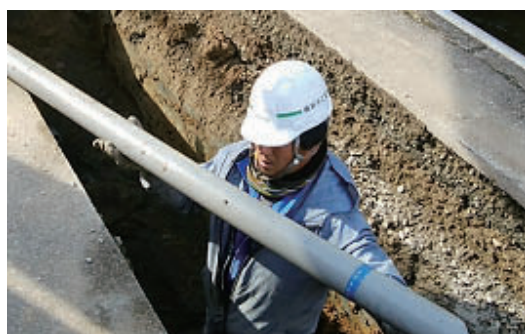
配水管の布設替 (長野市更北地区/令和元年度)
