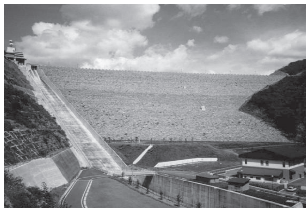
奥木曾発電所(H7.4 全部運転開始)
