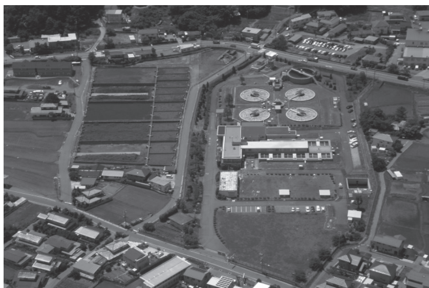
上田水道管理事務所 (H23.6 撮影)
