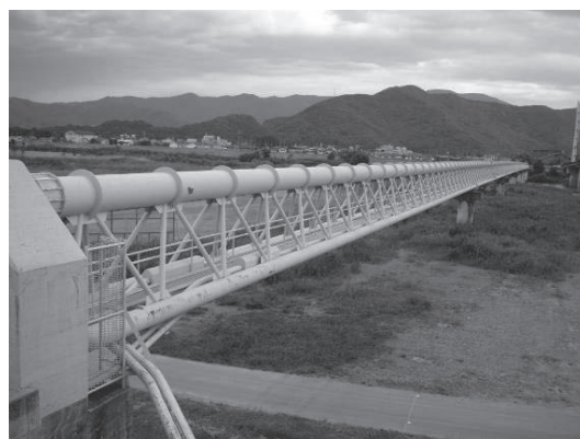
千曲橋水管橋
