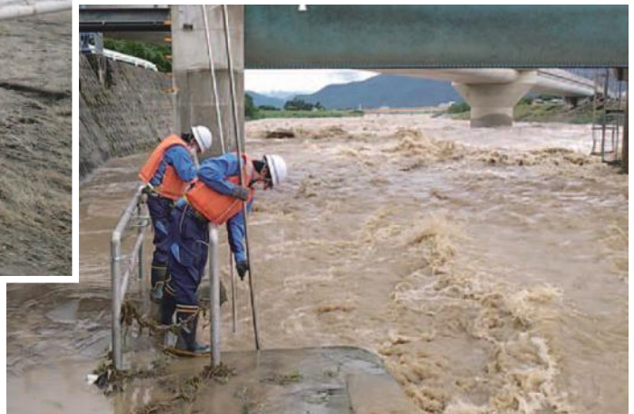
取水口での除塵作業（上田農水頭首工）
