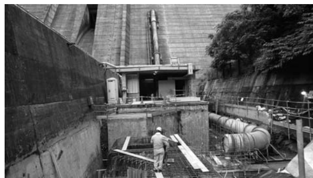
建設工事中の奥裾花第2発電所
