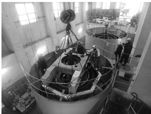
発電機解体中の美和発電所
