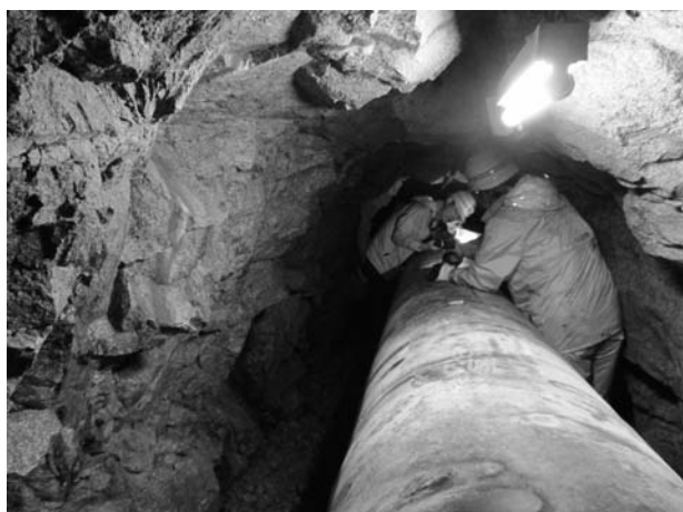
半過送水管トンネル点検状況
