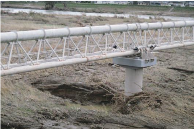
翌日の千曲川水管橋
