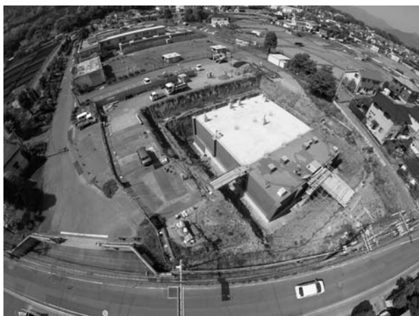
諏訪形浄水場新浄水池施工状況(2019年5月)
