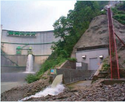
小渋第 3 発電所 (2000 年しゅん工)
