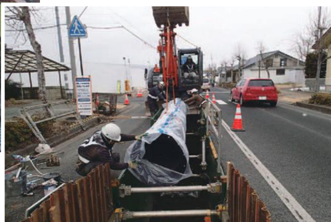
管路の耐震化工事
