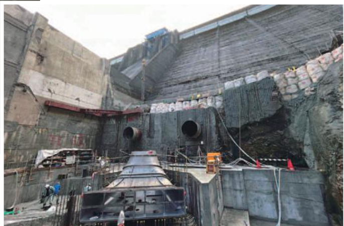
美和発電所 大規模改修
