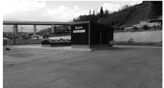
地下式に改修された西天竜発電所
