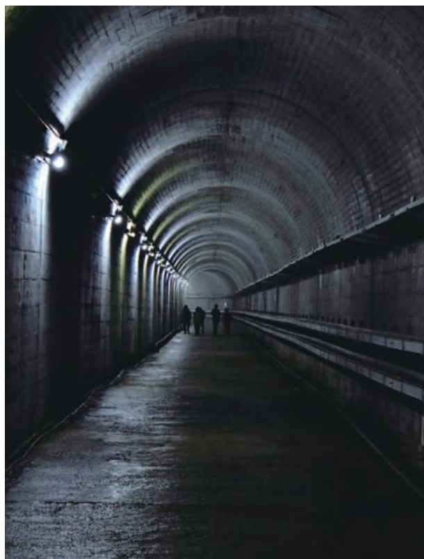
裾花発電所トンネル（長野市）
