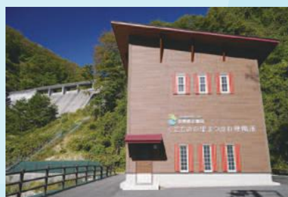
くだものの里まつかわ発電所 (2021 年しゅん工)
