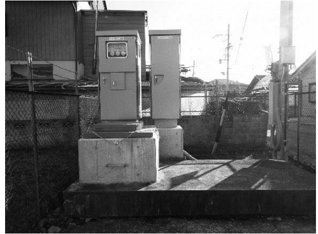
四ツ屋2号井戸ポンプ場浸水対策
