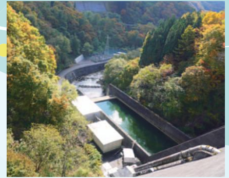
奥裾花第 2 発電所 (2017 年しゅん工)
