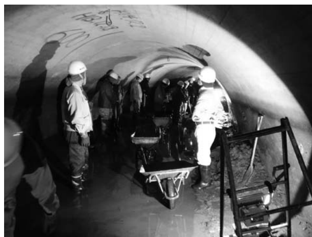
導水トンネル内の埋塞土除去
