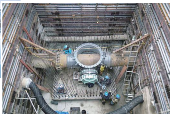
諏訪形浄水場新浄水池への送水管の分岐工事
