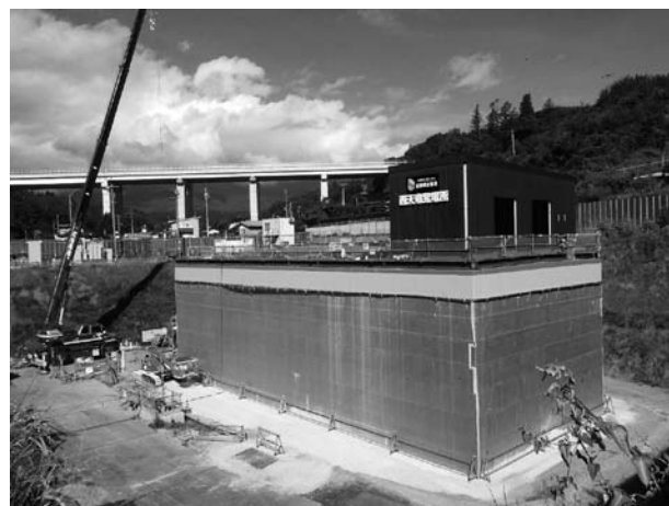
地下式に改修工事中西天竜発電所 < 2021年8月撮影 >
