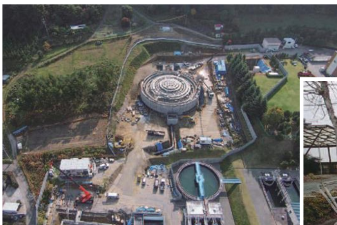
本山浄水場新浄水池築造工事
