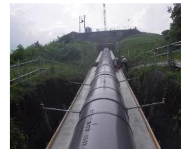
水圧鉄管(工事中)
