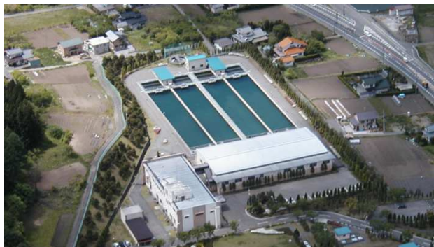
本山浄水場（塩尻市）
