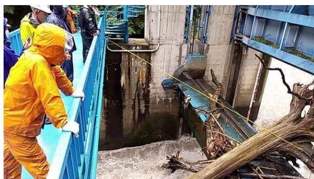
片平取水口の流木除去の様子（令和2年7月豪雨時）
