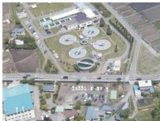
諏訪形浄水場
