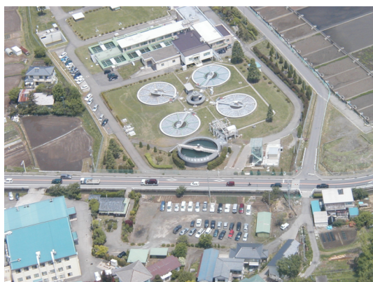
諏訪形浄水場
