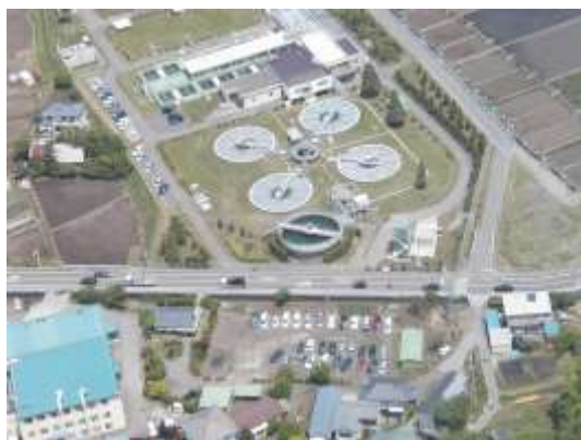
諏訪形浄水場
