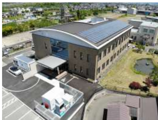
四ツ屋浄水場
