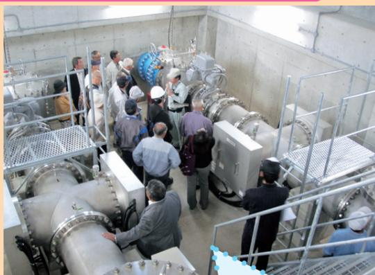
四ツ屋浄水場の**紫外線処理設備**を見学している様子です。ここでは、塩素滅菌されにくい細菌の処理を行っています。
