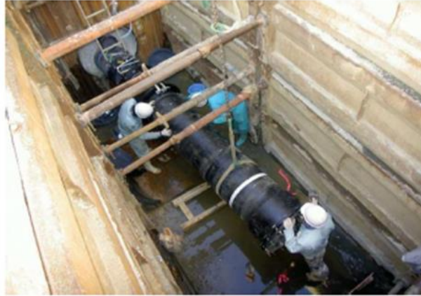
水道管の耐震化工事の様子
