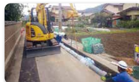
配水管の耐震化工事
