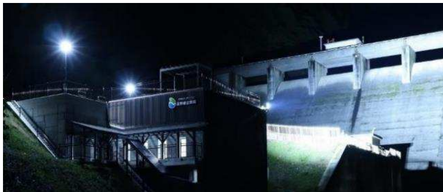
ライトアップ中の発電所
