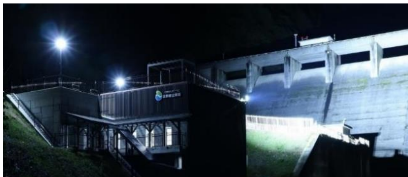
ライトアップ中の発電所
