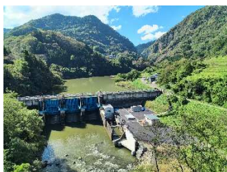
湯の瀬ダムと湯の瀬いとおしき発電所
