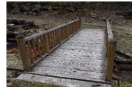
公園施設長寿命化計画に基づく施設更新
