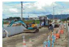
道路築造工事の土工作業風景
