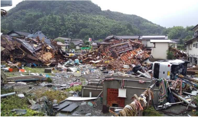
くま 球磨川右岸における家屋倒壊状況 くま (熊本県球磨村)
