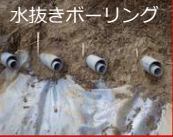
水抜きボーリング
