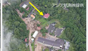
土砂災害の状況 うげん 長崎県雲仙市
