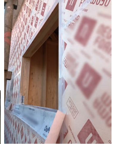
窓台に先張り防水シートを施工。
