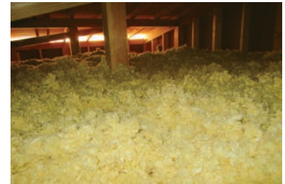
天井の断熱は、専門工事業者による吹込工法が施工精度を確保しやすい。
