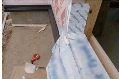
窓台に張った先張り防水シートのコーナー部は伸縮性のある防水テープを張る。
