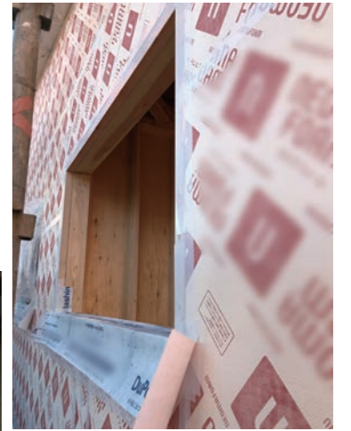
窓台に先張り防水シートを施工。
