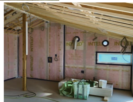
断熱材を隙間なく充填し、防湿シートを連続させて施工。
