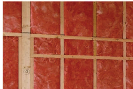
壁に断熱材(グラスウール)を充填したところ。断熱材の施工では、隙間なく隅々まで丁寧に充填することが重要なポイント。
