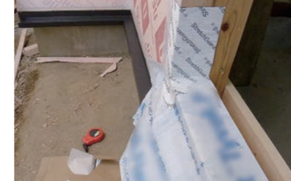
窓台に先張り防水シートのコーナー部は伸縮性のある防水テープを張る。
