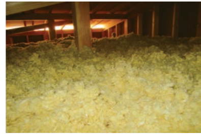
天井の断熱は、専門工事業者による吹込工法が施工精度を確保しやすい。
