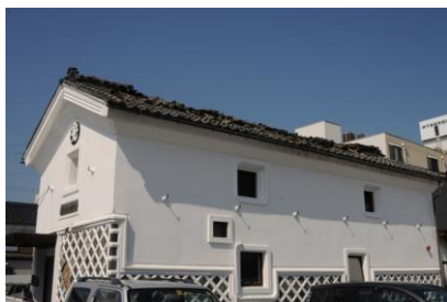
長野県中部の地震（H23.6.30）
