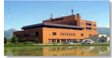
【災害拠点の割増補強】 (松本合同庁舎)
