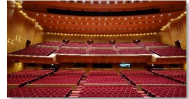
【吊り天井等の耐震化】 (ホクト文化ホール)
