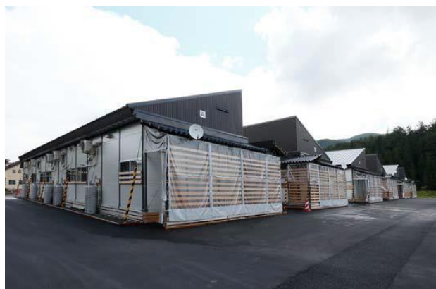
応急仮設住宅(長野県神城断層地震:白馬村)
