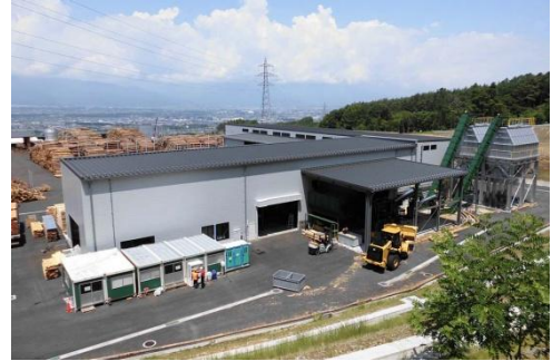
信州 F・POWER プロジェクト 木材加工施設
