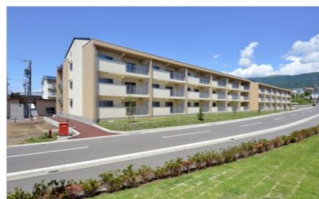
公営住宅の協働建替え (君石団地：塩尻市)
